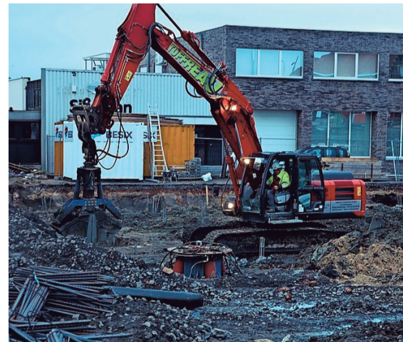
De werken voor de bouw van een nieuw OC in Lauwe zijn eindelijk gestart. Foto Xavier Coppens
